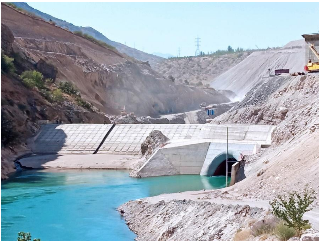
Рисунок 12. Строительная площадка Нижне-Чаткальской ГЭС в Узбекистане. Источник: коалиция «Реки без границ».
