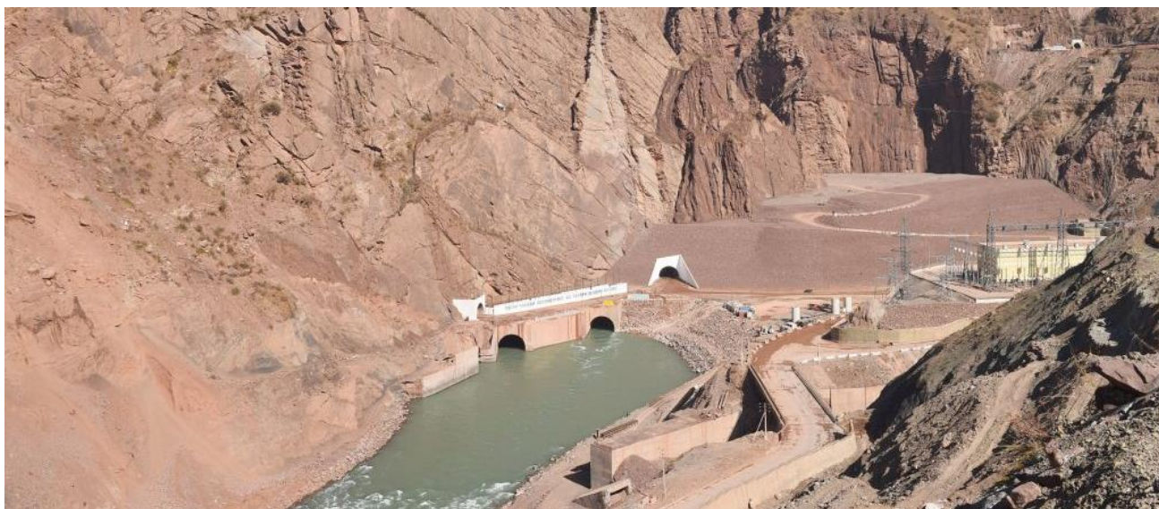
Выходной портал строительного тоннеля Рогунской ГЭС (фотография с официального веб-сайта ОАО "Рогунская ГЭС")
