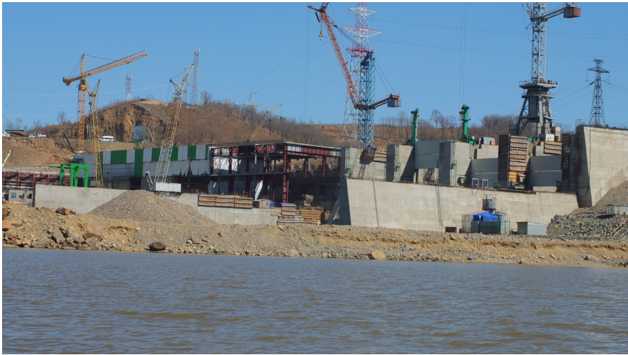
Строящиеся НБГЭС, апрель 2016 г.
