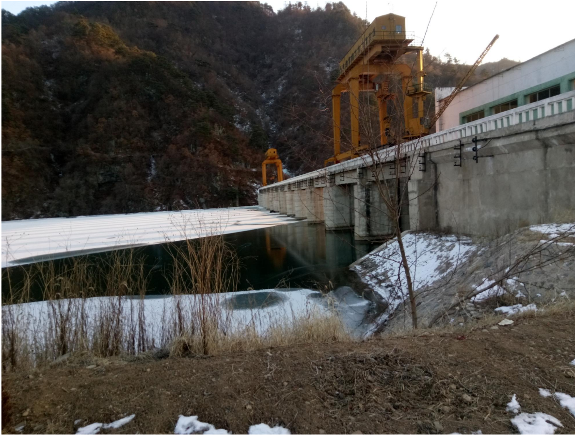
ВИД ВЫШЕ ПЛОТИНЫ
