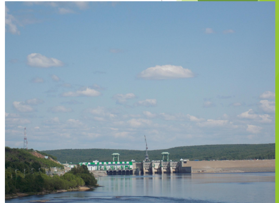
Строящиеся НБГЭС, май 2018 г.
